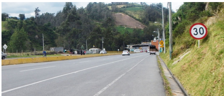
Figura 1. Puente internacional de Rumichaca cerrado, vista desde Ipiales (Colombia)
